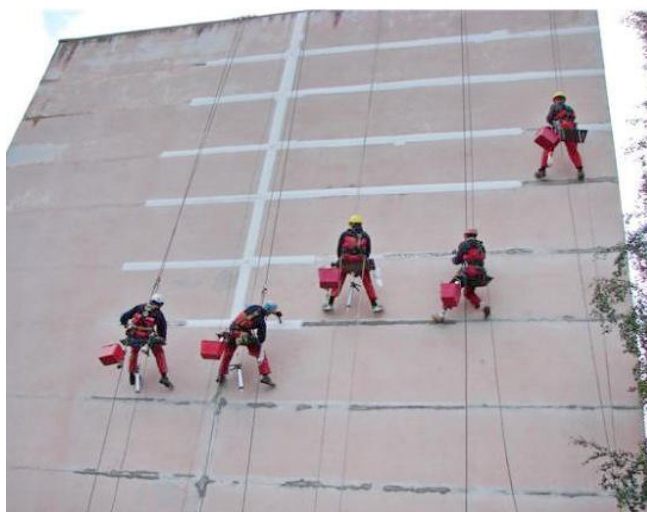
Рис.4 – Изоляция швов панельного дома жидкой теплоизоляцией RE-THERM
