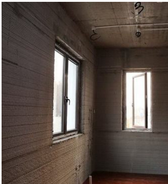
Рис. 3 - Пятиэтажный дом Winsun
