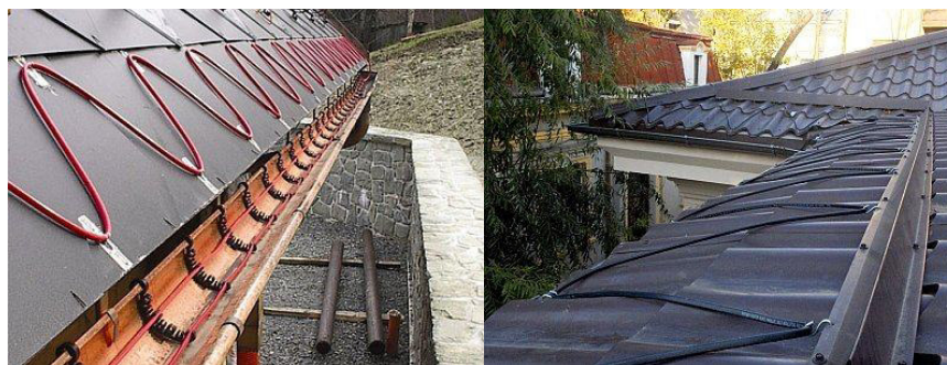
Рис. 5. Варианты размещения кабеля
