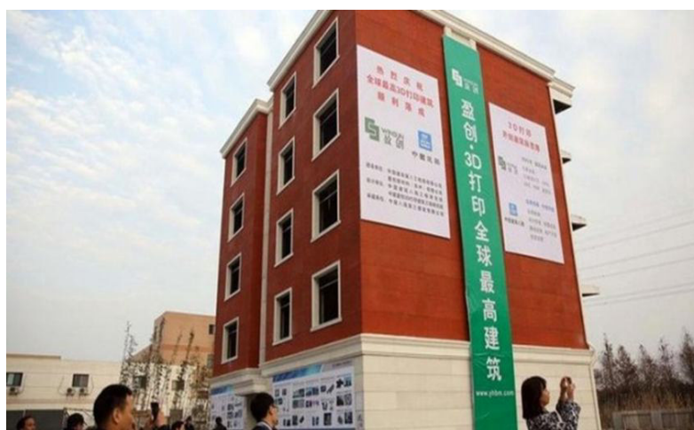
Рис. 2 – Пятиэтажный дом Winsun
