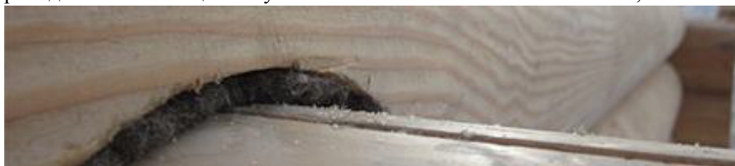
Рис.3 – Межвенцовый утеплитель «Klimalan»
